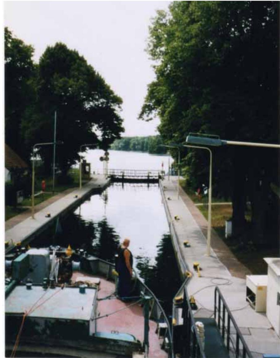
Ein Frachtkahn ist vom Flakensee in die Schleuse gefahren, um zur Fahrt in den Kalksee 2 m runtergeschleust zu werden. - S. 59: Das polnische Binnenschiff kommt vom Kalksee (S. 34 oben) und wird zur Weiterfahrt nach Berlin durch Wasser vom Flakensee um 2 m gehoben. An der Einfahrt zur Schleuse (S. 33) ist die Straßenbrücke hochgeklappt worden. (19 Fotos aus Woltersdorf: St., 23. 7. 2008)
