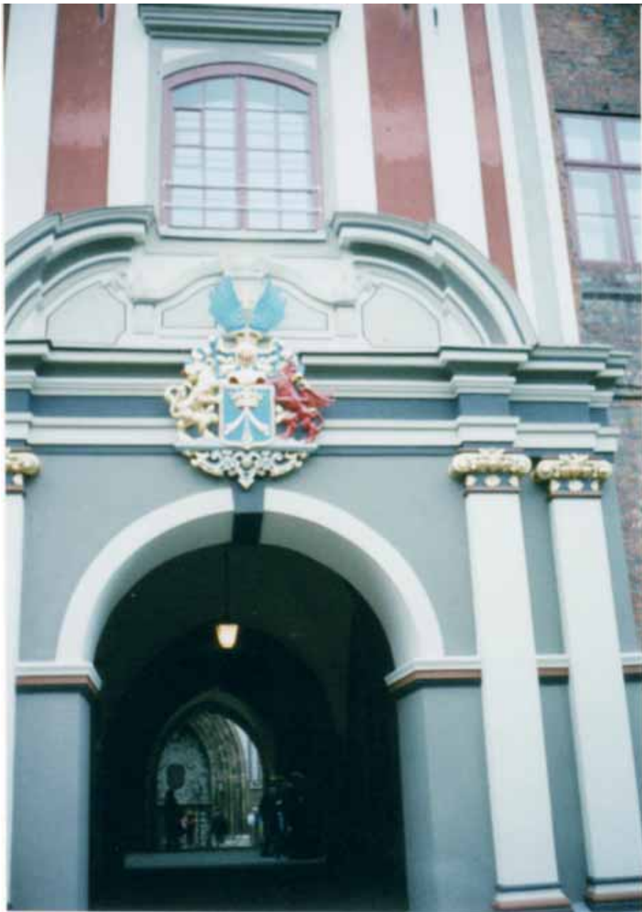
Das Barockportal von 1810 ist an der Westseite des Rathauses. Durch den Gang kommt man zur Ostseite.
