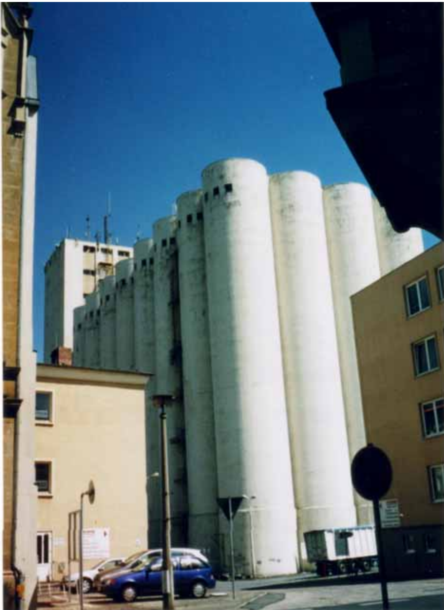
Zu Nr. 344 (Okt.), S. 14 - 34: Riesaer Getreidelager GmbH: Kornspeicher zwischen der Bahnhofstraße und dem Ufer der Elbe (Foto: St., 29. Juli 2008)
