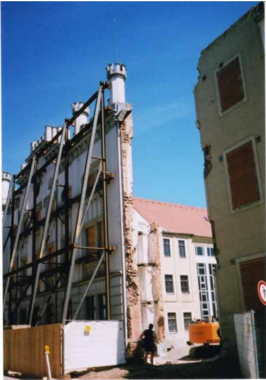
Das Rathaus (Vgl. Seite 19!) wird jetzt saniert - nur die Fassade bleibt. (Foto: St., 27. 7. 2009)
