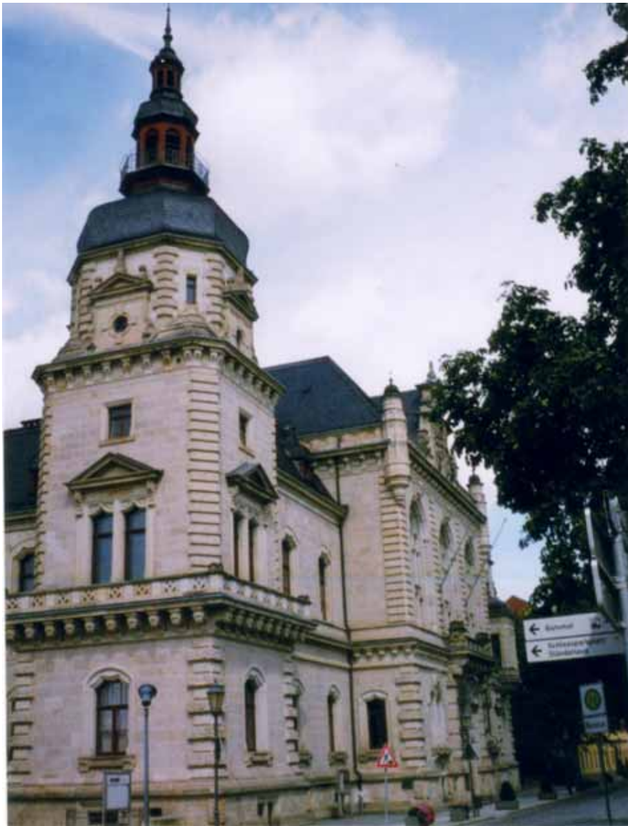
Merseburg: Ständehaus 52 ; S. 19: Dom (S. 20) und Schloß (S. 21, 22) oberhalb der Saale; 23: Neumarktbrücke; 24 und 25: Willi-Sitte-Galerie; 26: Krummes Tor; 28, 29, 32: Chemie-Museum; 30: Altes Rathaus; 33: Eulenturm (16 Fotos: St., 31. 7. '09)
