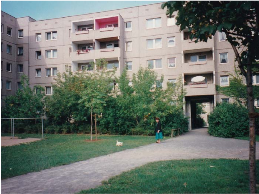
Sozialer Wohnungsbau in der DDR: Plattenbau in Berlin-Hellersdorf (Foto: St., 30. 8. '96)
