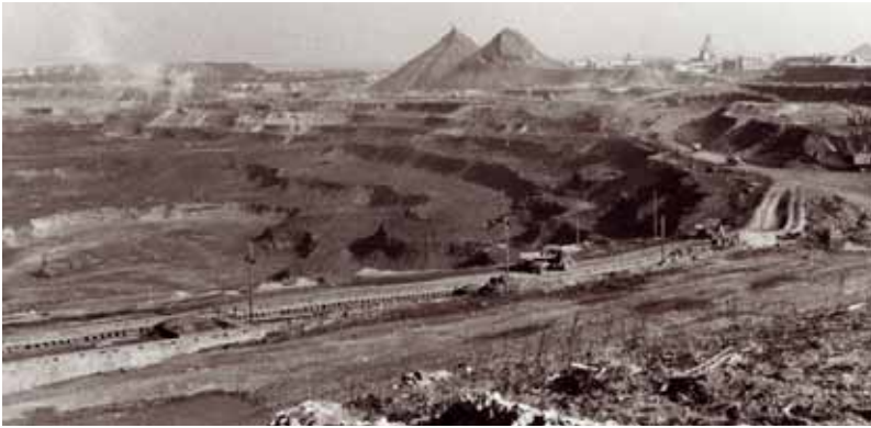
Tagebaugelände der Wismut AG etwa 1960
