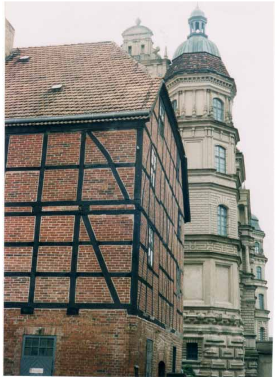
Güstrow (S. 24!): Die Wollhalle ist ein 500 Jahre altes Fachwerkhaus. Die Fächer zwischen den Balken sind mit Backsteinen (Ziegelsteinen) ausgemauert.
