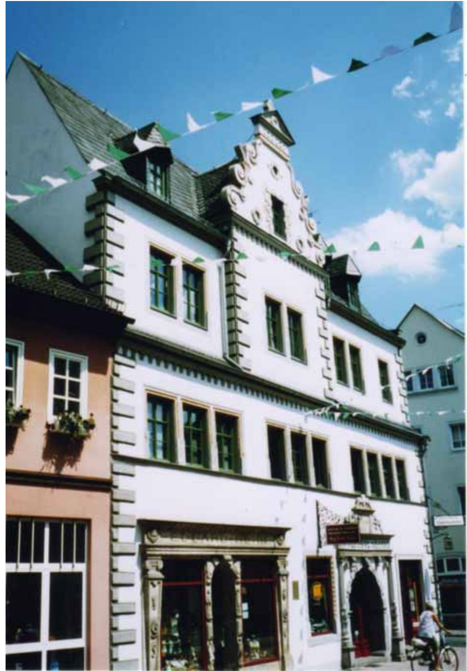
Saalfelder Bürgerhaus von 1609
