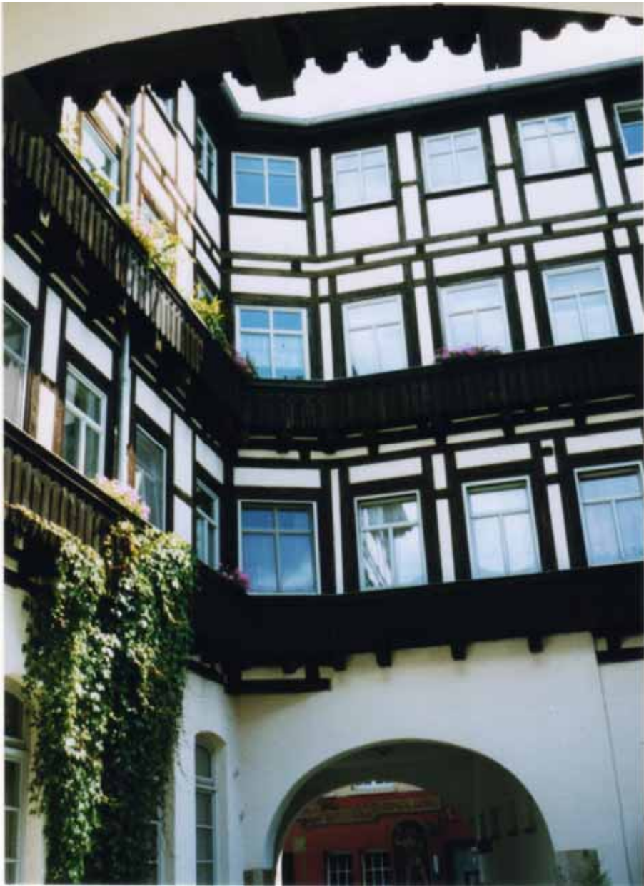
Hinterhof des Hauses Brudergasse 9: drei Fachwerk-Stockwerke über dem aus Steinen errichteten Erdgeschoß (17 Fotos aus Saalfeld: St., 2. Juli 2008)
