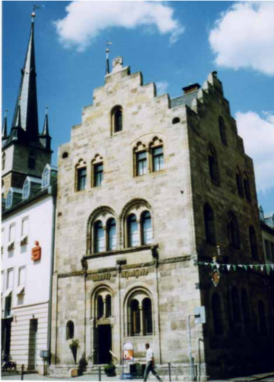
Im 1180 errichteten Wohnturm des Stadtvogts ist die Markt-Apotheke (S. 38, Z. 8). Links hinter der Sparkasse sieht man einen Turm der Johanneskirche.
