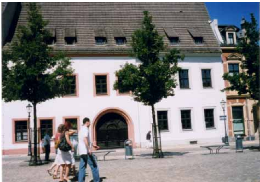
Zwickauer Ackerbürgerhaus von 1539 mit einem Tor für die Erntewagen mit der Ernte von den Äckern vor der Stadtmauer (Foto - und auch die 5 folgenden -: Steinberg, 27. Juli 2009)
