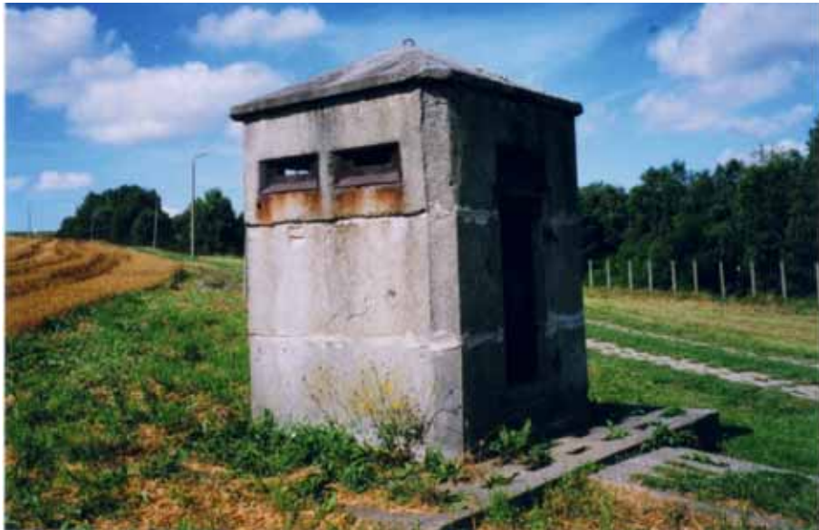
Teistungen 34 (bis 1990: DDR): Kolonnenweg 87 und Beobachtungsbunker an der ehemaligen DDR-Grenze
