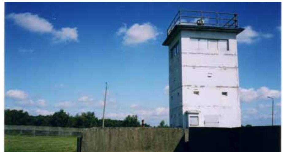
Teistungen 34 : Beobachtungsturm der DDR-Grenztruppen (Bis zum Grenzzaun hatte man die Bäume abgeholzt, um freies Schußfeld zu schaffen.)
