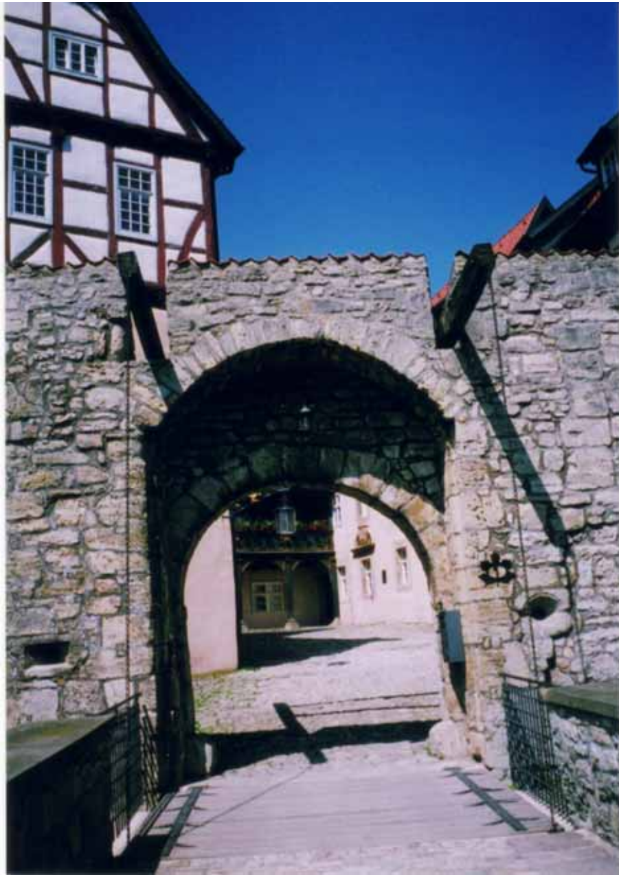
Zugbrücke vor Burg Bodenstein 43 , S. 27: Aufgang zur Kapelle unter der Sonnenuhr, S. 29: in der Kapelle
