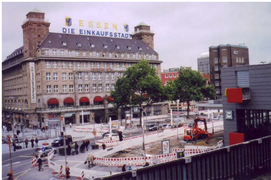
Essen: Handelshof (Hotel), „Haus der Technik“ und Hauptbahnhof (Baustelle) - St., 10. 9. '10
