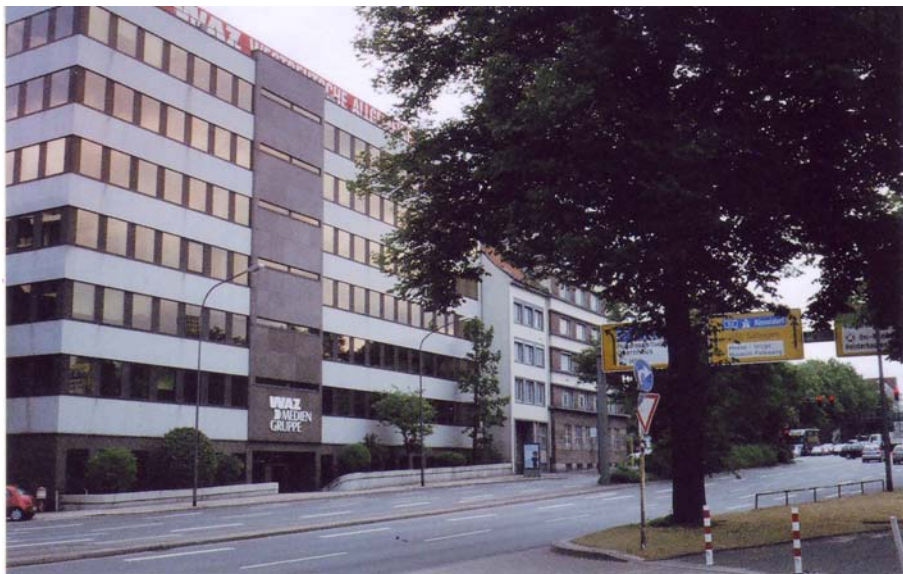
WAZ 6 -Gebäude an der Friedrichstraße (6 Fotos: St., 6. 7. '10)
