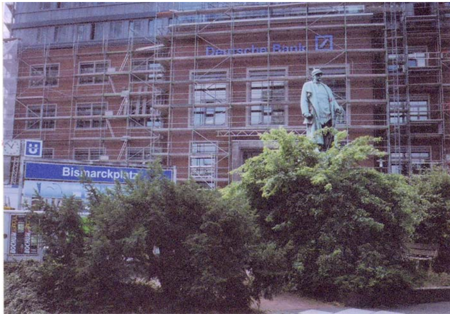
Bismarck-Statue auf dem Bismarckplatz vor der Deutschen Bank (Gerüst: Fassaden-Erneuerung)
