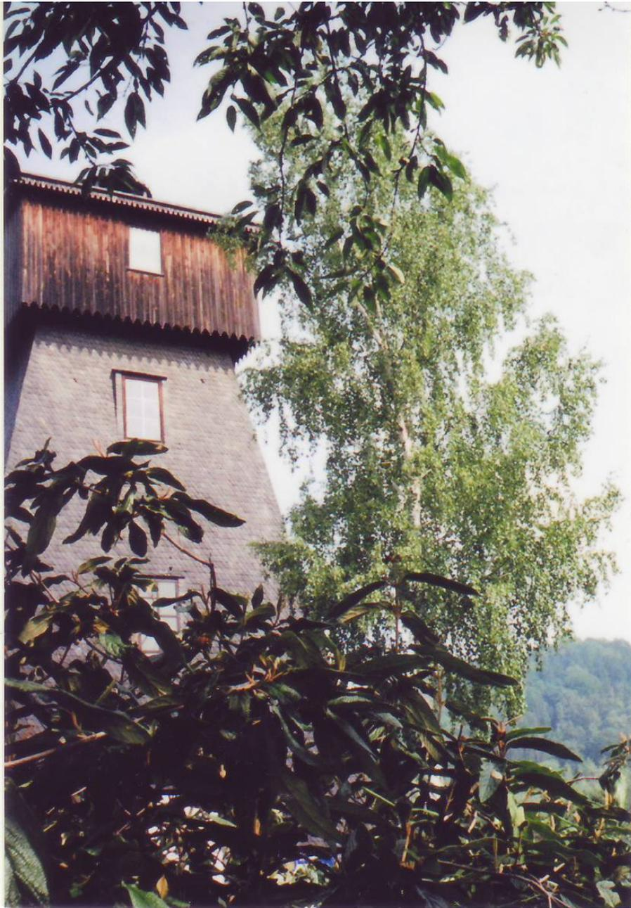
Dieser Bohrturm mit Holz- und Schieferverkleidung<sup>45</sup> hat dazu gedient, durch eine Bohrung an die Sole heranzukommen, um sie hochzupumpen. Vgl. S. 3, Z. 9, bis S. 4, Z. 2! (11 Fotos: St., 14. 8. 2010)
