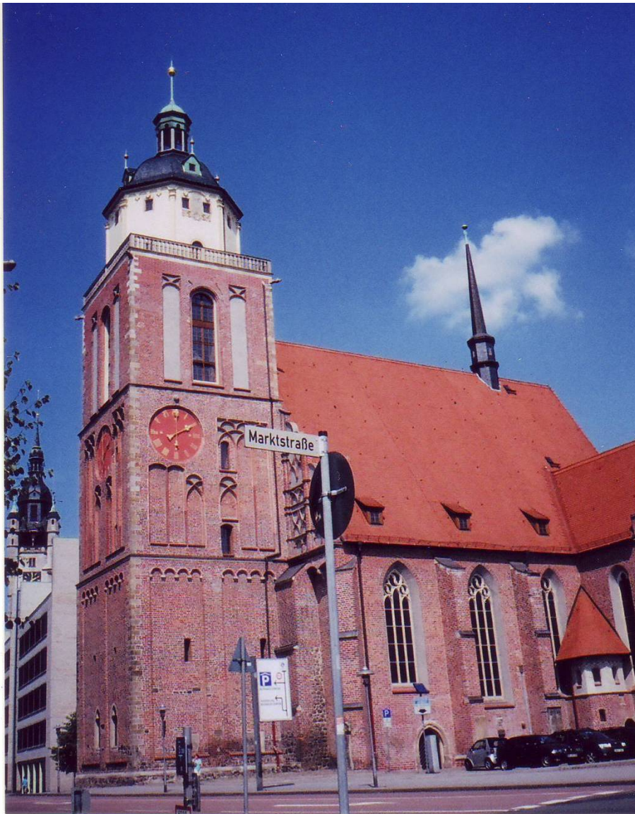
Die Dessauer Marienkirche ist ein Backsteinbau aus dem 16. Jahrhundert. Ganz links erkennt man den Rathausturm. S. 6 und 7: Der Johannbau ist vom 1533 erbauten Schloß übriggeblieben. S. 6 links: die Turmspitze der Marienkirche, S. 7 rechts: die Spitze des Rathausturms. S. 9: 1929 von Gropius 20 als Arbeitsamt erbaut. (5 Fotos: St., 10. 8. 2010)
