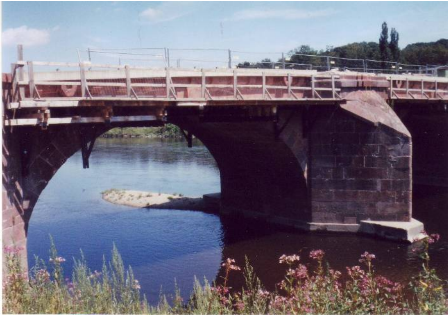
Brücke über die Mulde (Pöppelmann, 1719)
