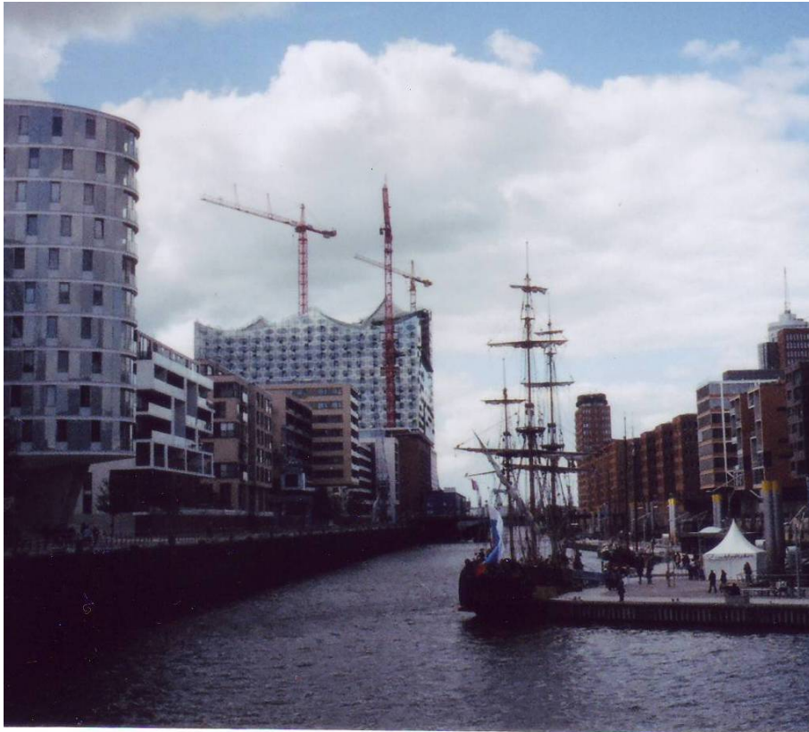
Kräne über der „Elbphilharmonie“ in der Hamburger „Hafen-City“; S. 61: Blick von der Poggenmühlenbrücke, Speicher-Block X (4 Fotos: St., 21. 7. 12)
