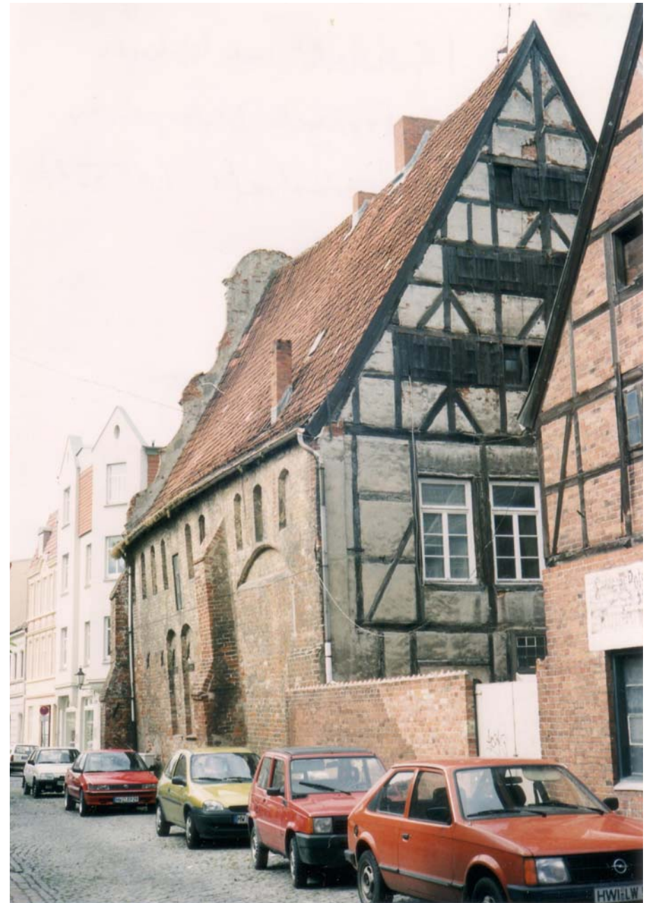
Wismar , Hundestraße: Speicher von 1550, jetzt mit Wohnung im 1. Stock, Dachspeicher in 3 Stockwerken
