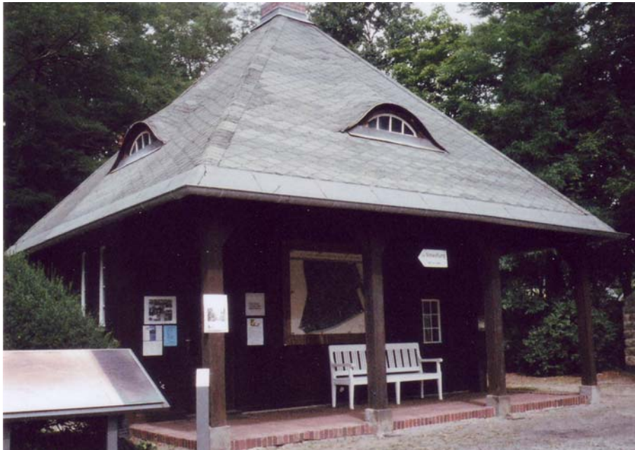
Holzhäuschen rechts (und links) vom Eingang
