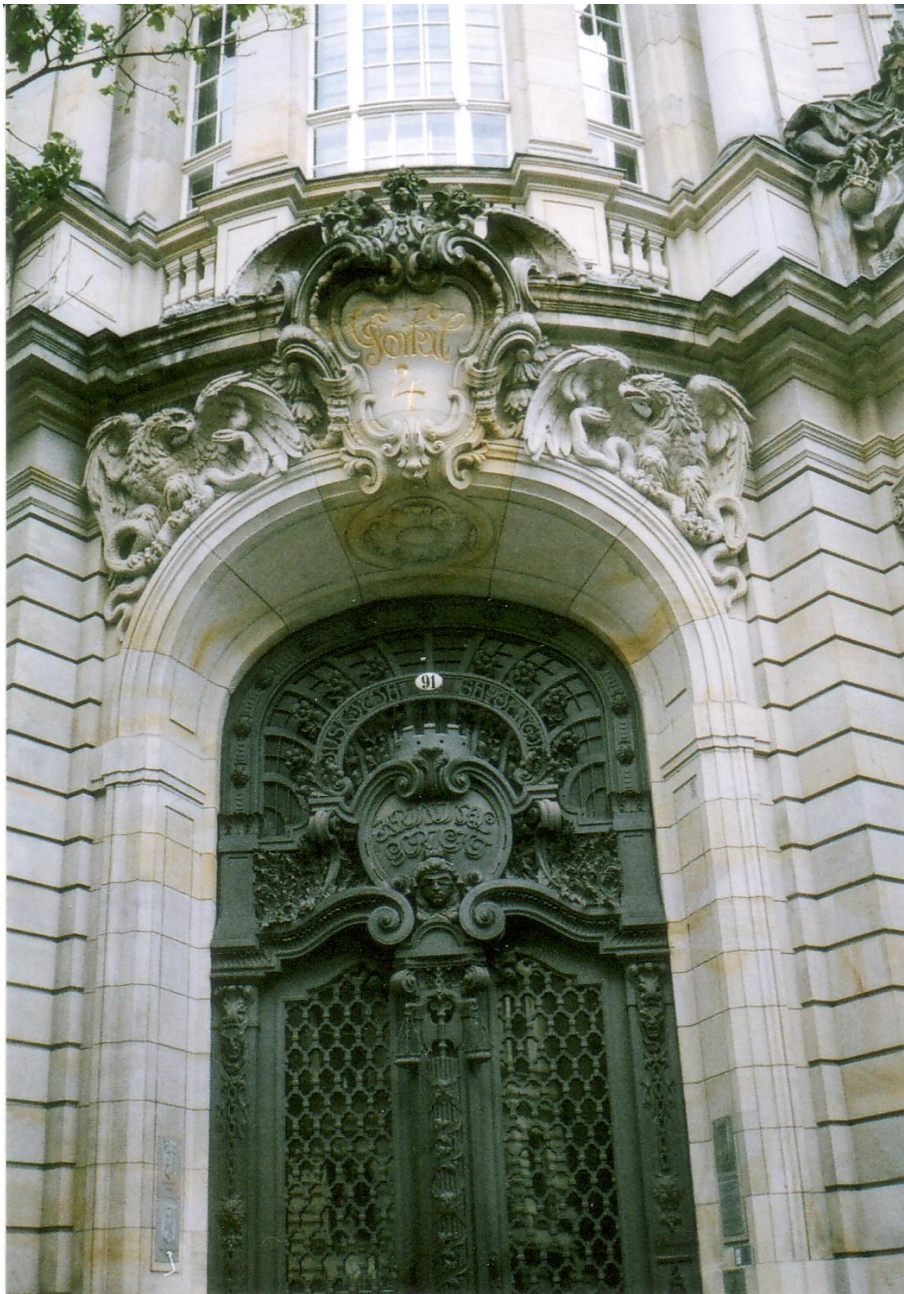
Berlin-Moabit, Turmstraße 91: Portal 4 des Kriminalgerichts (S. 51), dahinter: das Gefängnis, Rathenower Straße (S. 53) (Fotos: St., 13. Juli '13)
