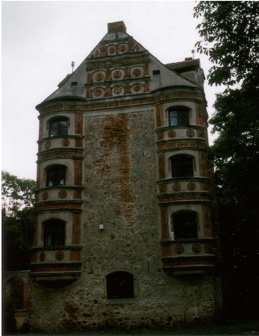
Freyenstein liegt 50 km nordöstlich von Wittenberge, 15 km nordwestlich von Wittstock. Das Schloß ist von 1550 - restaurierte Reste: S. 19! - S. 20: Girlanden vom Dorffest vor dem Rathaus von 1904. - S. 21: ausgegrabene Kellerwände aus Feldsteinen von 1250 im archäologischen Park: Seddin-Projekt!
