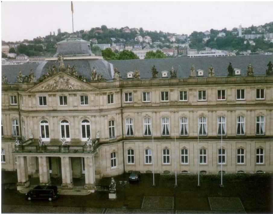
Stuttgart: Im 1746 - 1807 erbauten Neuen Schloß hat jetzt das baden-württembergische Finanzministerium seinen Sitz. Foto: St., 28. Juni 2013
