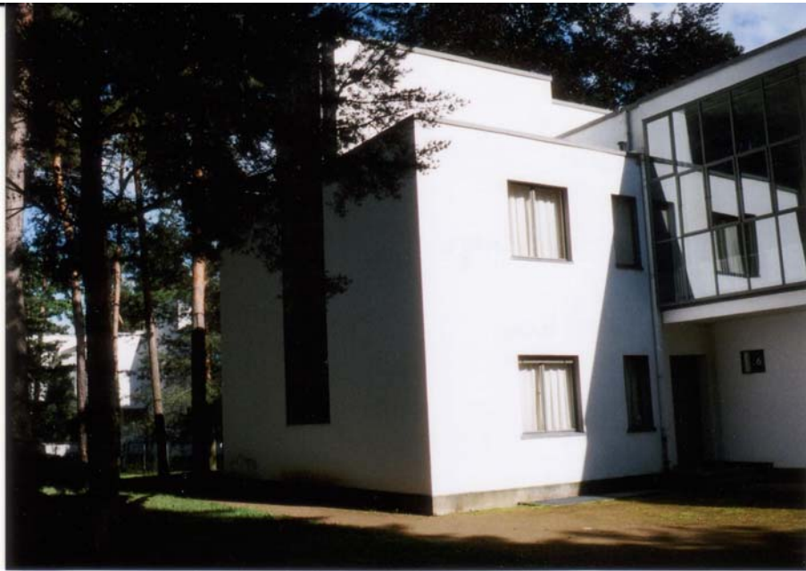
Dessau 53 : Bauhaus-Siedlung: „Meisterhäuser“ (St., 7. Juli 2012)
