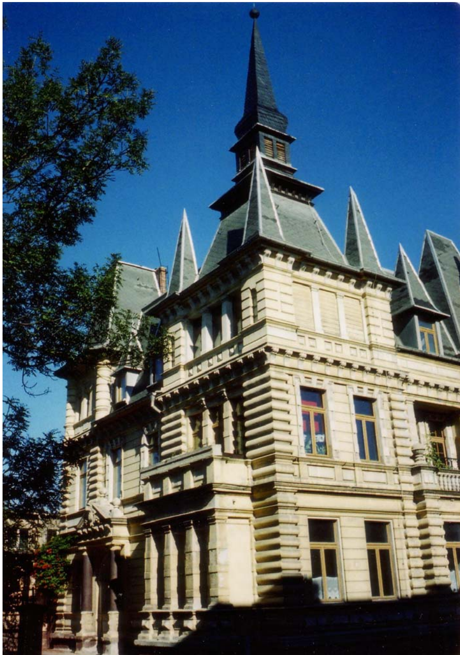
Die Villa in der Baasdorfer Straße ist von 1910. - S. 27: Dieses Mietshaus ist mit Stuck verziert.
