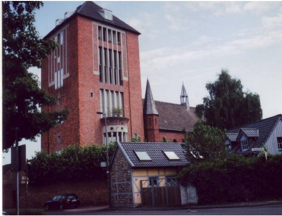
Köln-Rondorf: Im Kirchturm sind jetzt vier Wohnungen, im Kirchenschiff die Büros von drei Architekten. Foto: St., 25. 7. 2013
