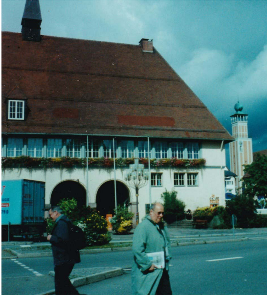
Freudenstadt im Schwarzwald 32 (1945 vollständig zerstört): Stadthaus, Rathaus-Turm (St., 21. 9. 2004)
