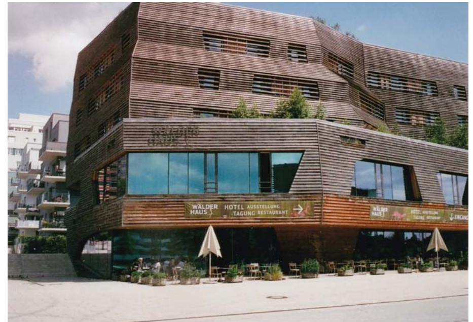
IBA-Gelände (auch Seite 33 und 34): „Wälderhaus“ aus Holz und nicht nur mit Holz als Fassade
