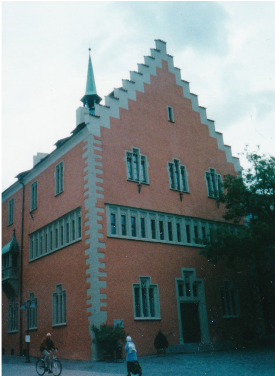
Ravensburg in Oberschwaben: Das Rathaus (auch auf Seite 28) ist von 1386. S. 28 links: das Waaghaus (städtisches Kaufhaus) von 1497 mit dem Blaserturn von 1553. S. 30: der Gemalte Turm ist von 1418.
