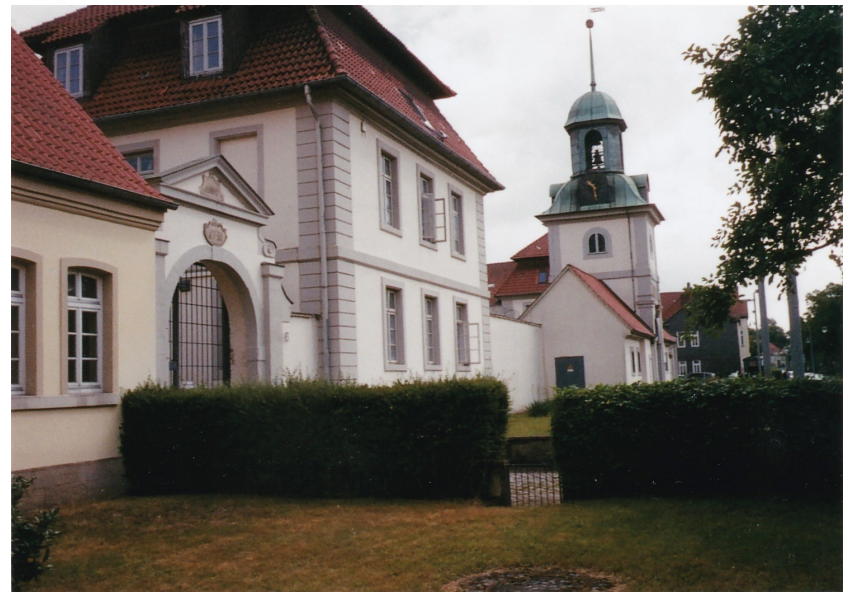
Zu Nr. 426, S. 1 - 16, und Nr. 436, S. 20 - 32 mit der Übungsaufgabe dazu in Nr. 436 auf Seite B: Zuchthaus in Celle von 1716, S. 17: der Wachturm Nr. 2 der JVA Celle (3 Fotos: St., 26. Juni 2017)
