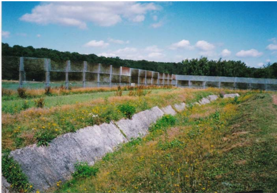
Teistungen (Vgl. 177, 27 - 38; 347, 34/35!) im Landkreis Eichsfeld, früher DDR: an der Grenze zum Westen noch zu sehen: Kraftfahr- zeug-Sperrgraben, Gitterzaun (18. 8. 2009)
