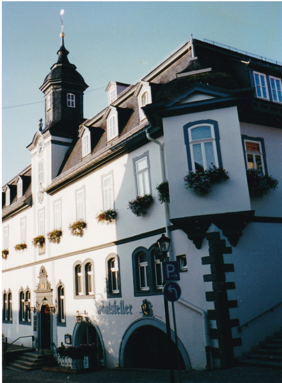
4 Fotos aus Ilmenau: S. 28: Buchhandlung Grimm, S. 29, 30 und 53: das nach dem Stadtbrand von 1752 ab 1768 wiederrichtete Rathaus mit dem Restaurant im Keller, dem Ratskeller (Steinberg, 5. 8. 2000)
