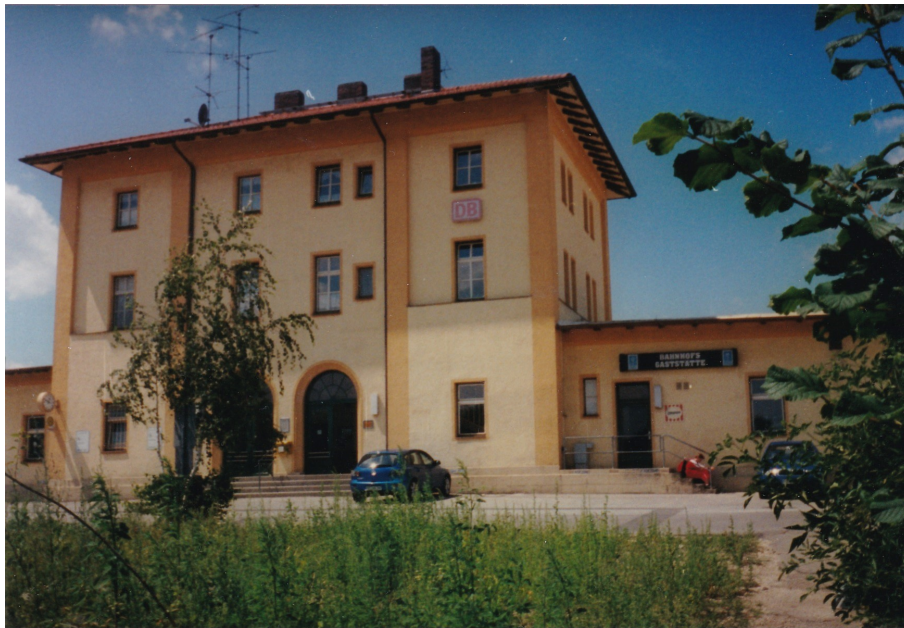
Rohrbach an der Ilm (3 Fotos: St., 17. Juli 2005): Bahnhofsgaststätte
