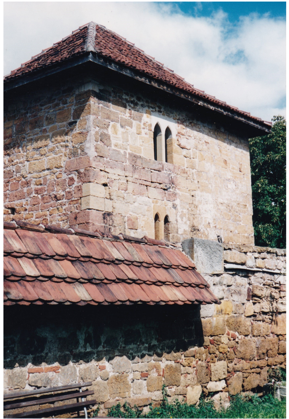
Wohnturm von 1597 - S. 29: Der Henningshof wurde gerade restauriert. (3 Fotos: St., 20. Aug. 1999)
