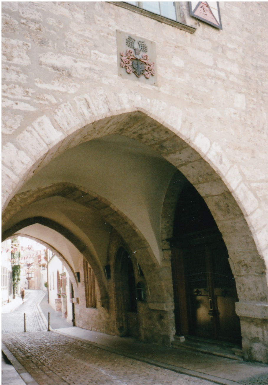
Das Rathaus wurde um 1300 erbaut. (4 Fotos: St., hier und S. 49: 3. 9. '16; 24 und 26: 23. 8. '19)
