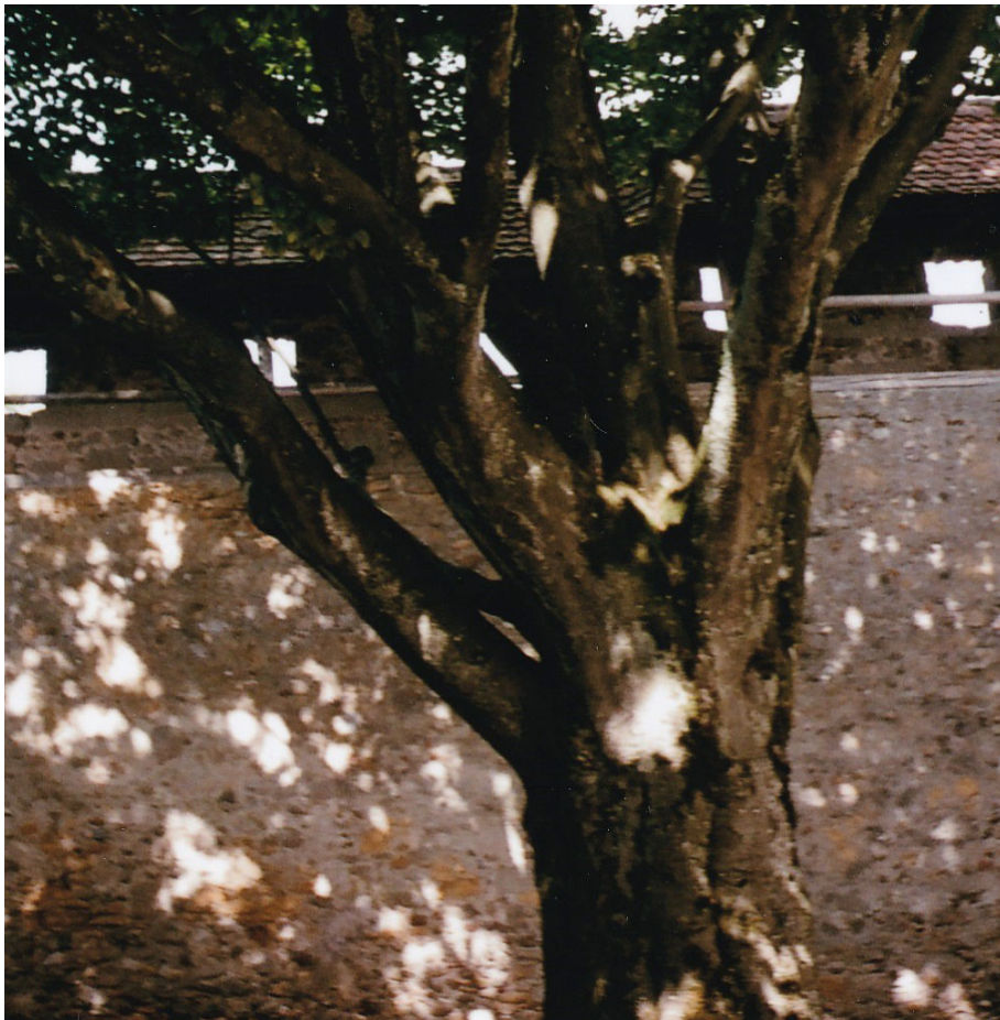
Murtener Stadtmauer (1238) mit Wehrgang (15. Jh.)
