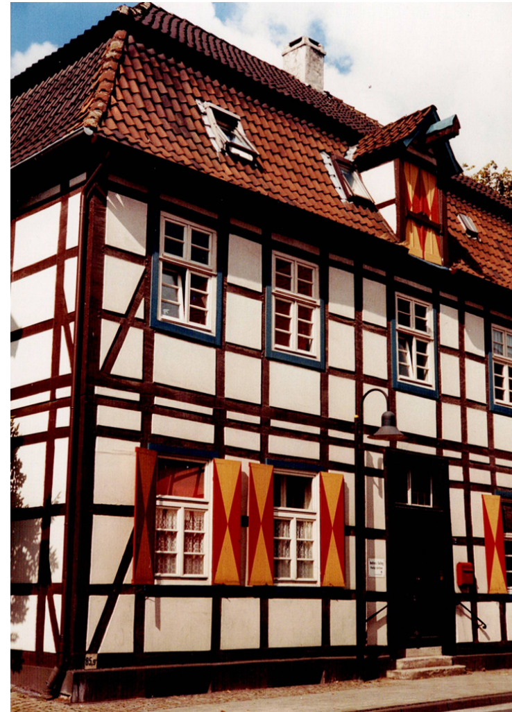
Paderborn-Neuhaus: Fachwerkhaus (St., 15. 8. 1999)
